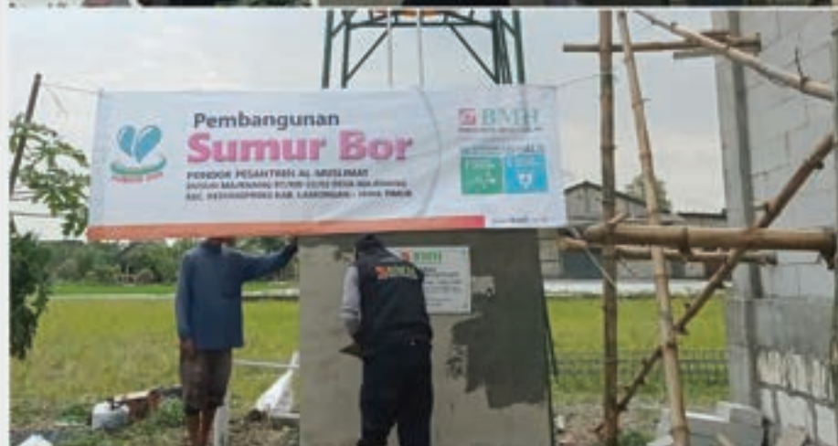
Pekerjaan Tempat Wudhu dan Instalasi
