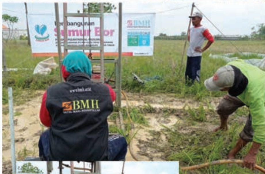
Proses Pengeboran Air Bawah Tanah (ABT) di lahan belakang Pesantren
