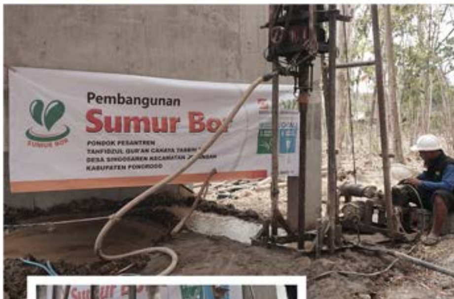
Proses Pengeboran Air Bawah Tanah (ABT) di Lahan Pesantren
