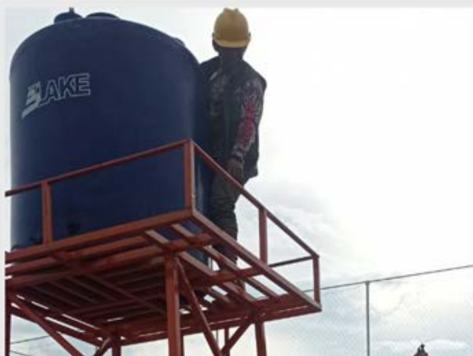
Pekerjaan Instalasi Tandon Air
