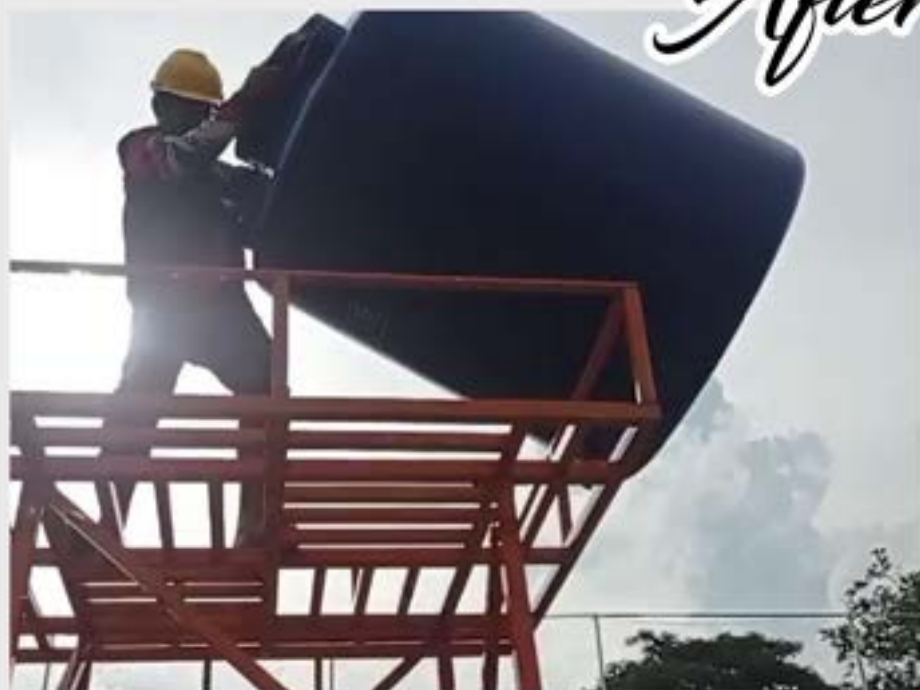
Pekerjaan Instalasi Tandon Air
