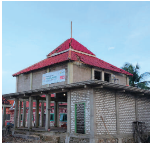
Progres Masjid Umi Abi Pesantren Pedalaman Pulau Sabuntan, Sumenep Ket : Persiapan Pasang Granit Lantai
